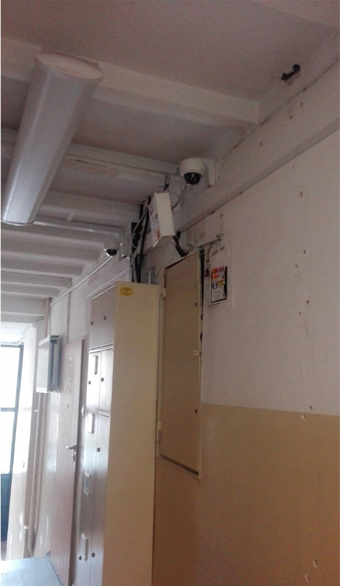
AL. NIEPODLEGŁOŚCI 71 A - REOMONT KLATKI SCHODOWEJ (PRZED REMONTEM) / LISTOPAD 2018
