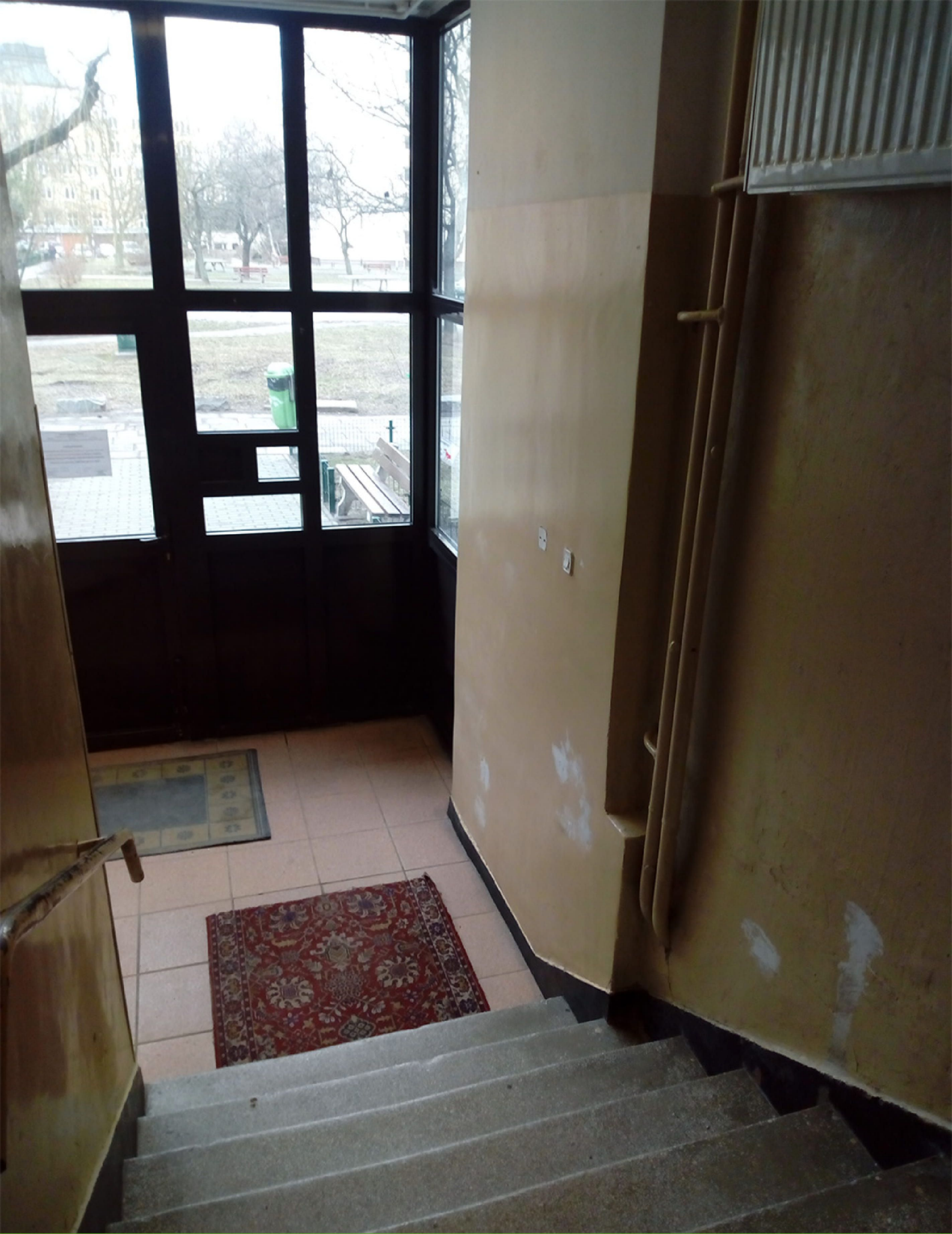
AL. NIEPODLEGŁOŚCI 71 A - REOMONT KLATKI SCHODOWEJ (PRZED REMONTEM) / LISTOPAD 2018
