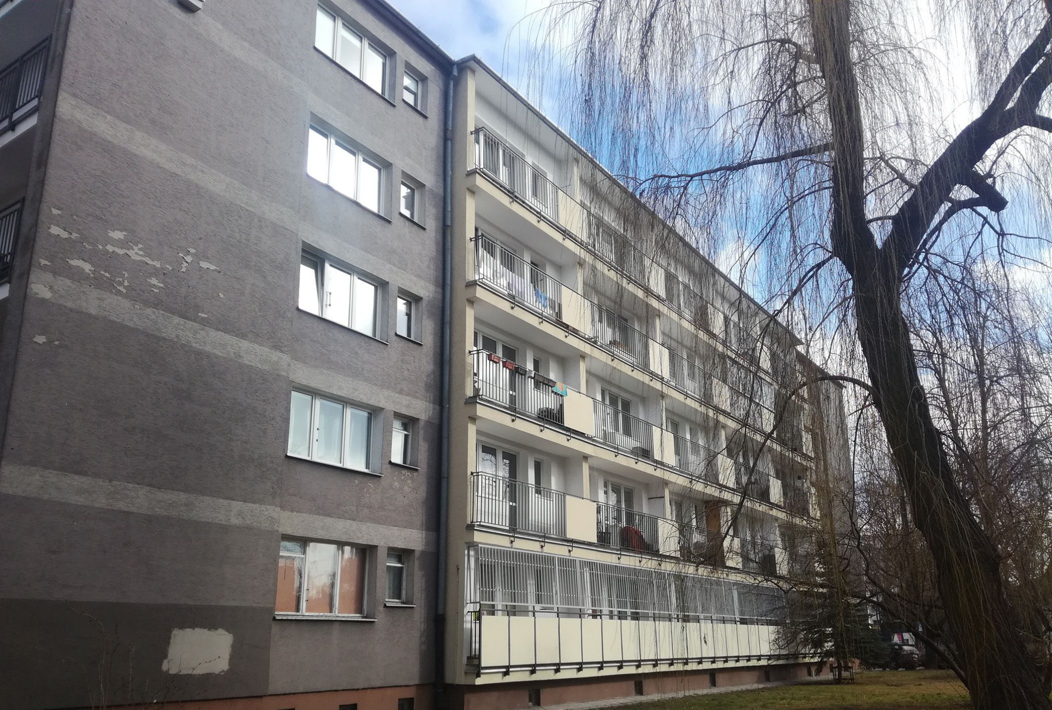
KSAWERÓW 22 - PRZED REMONTEM
